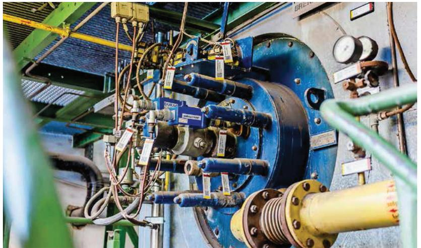
**Einsatz von KKS an einem Kessel – über 4.800 Schilder wurden im Kraftwerk am K+S-Standort Sigmundshall montiert.** Foto: Phoenix Contact
