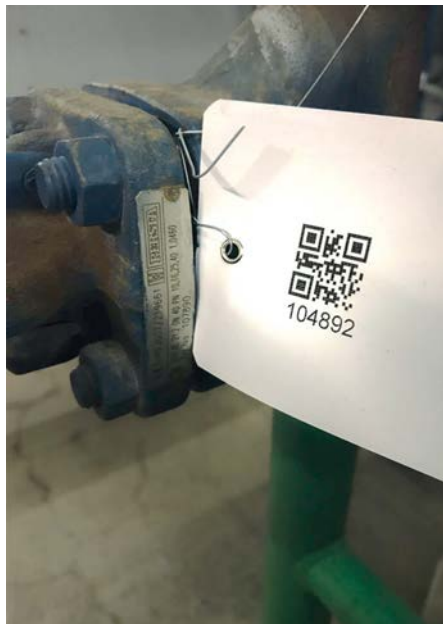
Bild 9. QR-Code mit ID-Schild an Typ und Hersteller für AS BUILT Aufnahme.
